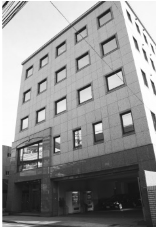
野村鋼機(株)本社ビル
