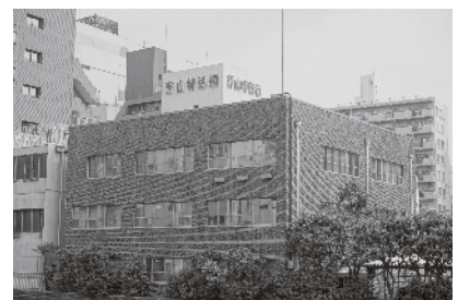
青山特殊鋼の社員を50年間支えてきた本社ビル。褐色系で濃淡のあるタイルを使用した外観が風格を感じさせる。
