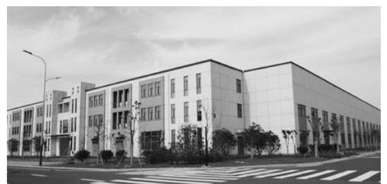
2015年9月に始動した山進特殊鋼・外観
