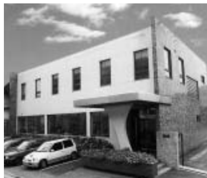
ユアーズスチール本社外観
