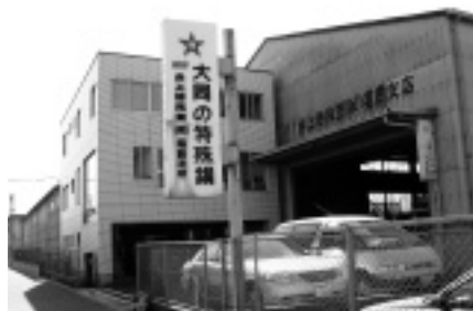
井上特殊鋼福岡支店社屋全景
