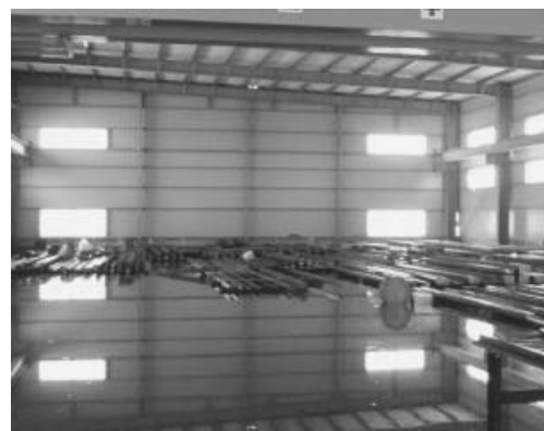
おおむね水が引いた3月23日の倉庫内状況。建材用途もあることから海水につかった鋼材の再生はあきらめ、約300トンを入れ替えた。
