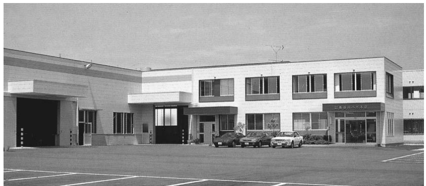
太田流通団地にテクニカルセンターも併設する長谷川ハガネ店本社
