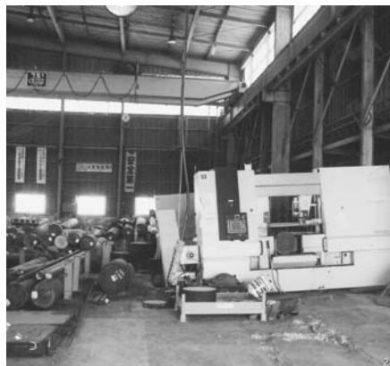
地盤沈下し、切断機が傾いた大丸切断工場
