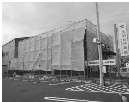
平成23年12月、復旧に向けて工事中のいわき営業所
